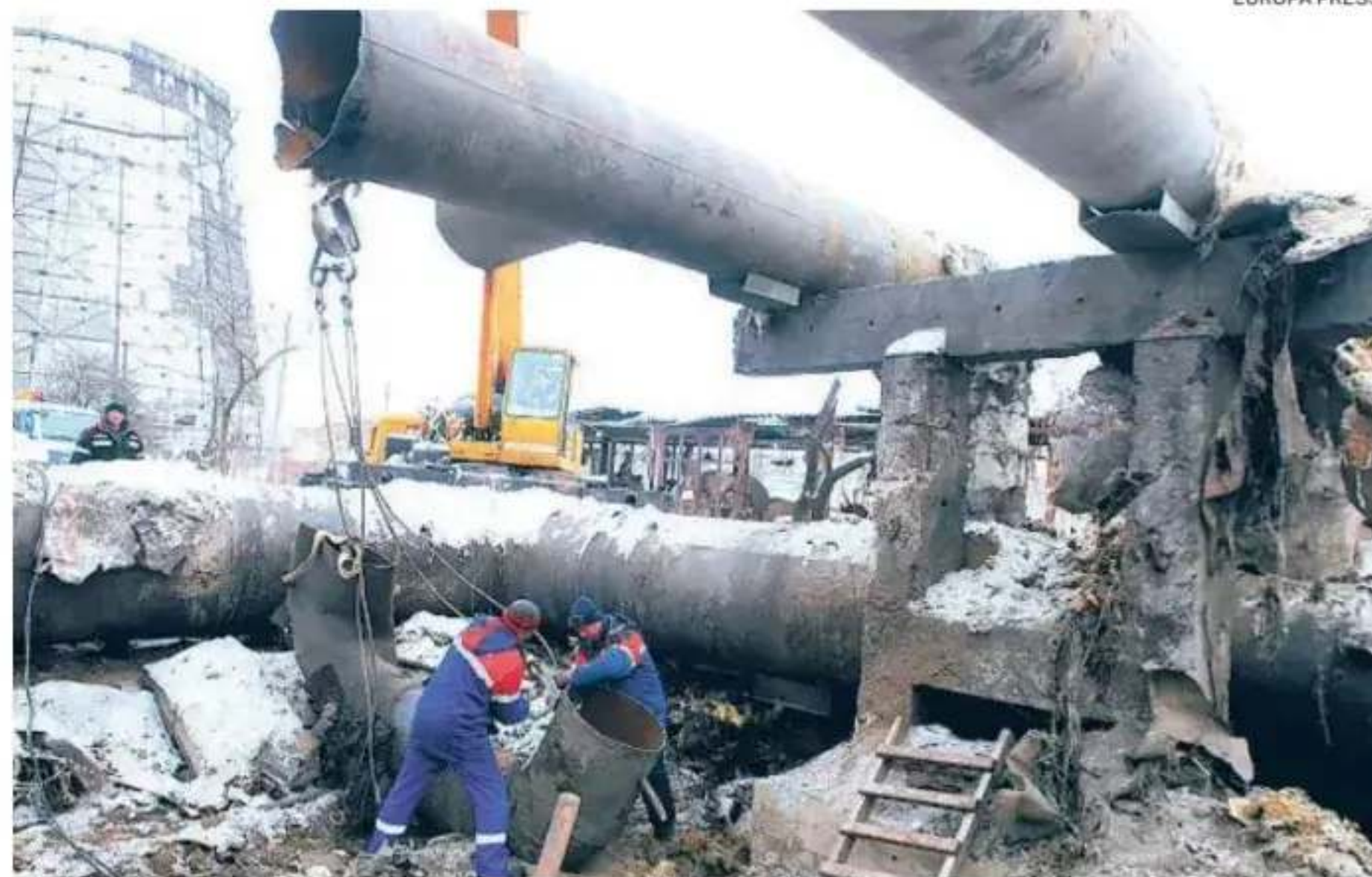
Técnicos reparan una tubería dañada por un ataque ruso en Kiev
